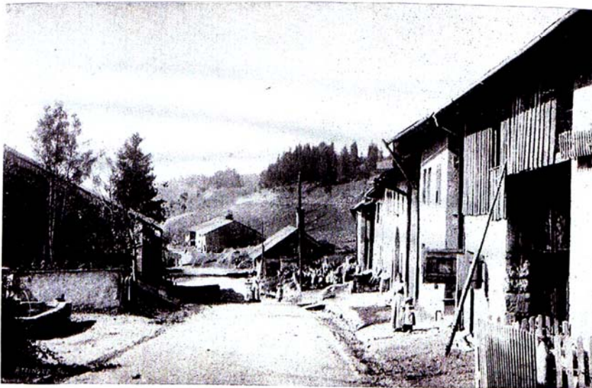
Dombrea, 1897, le bâtiment de la fromagerie est visible à droite de la rue du bas du village.
